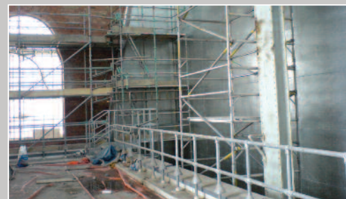
Les équipements d'accès aux normes, employés par Sharpfibre durant les travaux d'installation.
