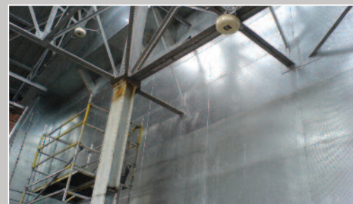
Les pénétrations de la charpente en place ont été soigneusement incorporée dans la nouvelle installation des panneaux DURASTEEL®
